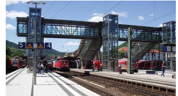
Abbildung 25: Barrierefreier Zugang zu den Gleisen
